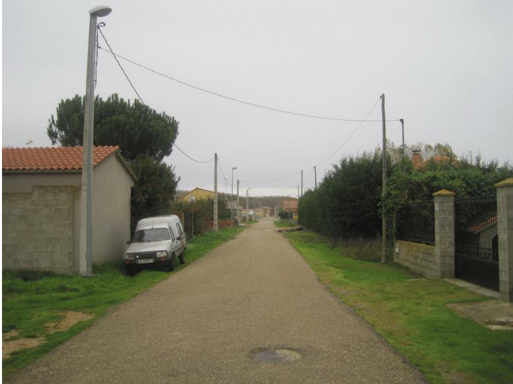
FOTOGRAFÍA 13. Al Sur de Santa Colomba de la Vega existen algunas urbanizaciones mal resueltas en las que es necesario completar el viario público y las redes de infraestructuras
