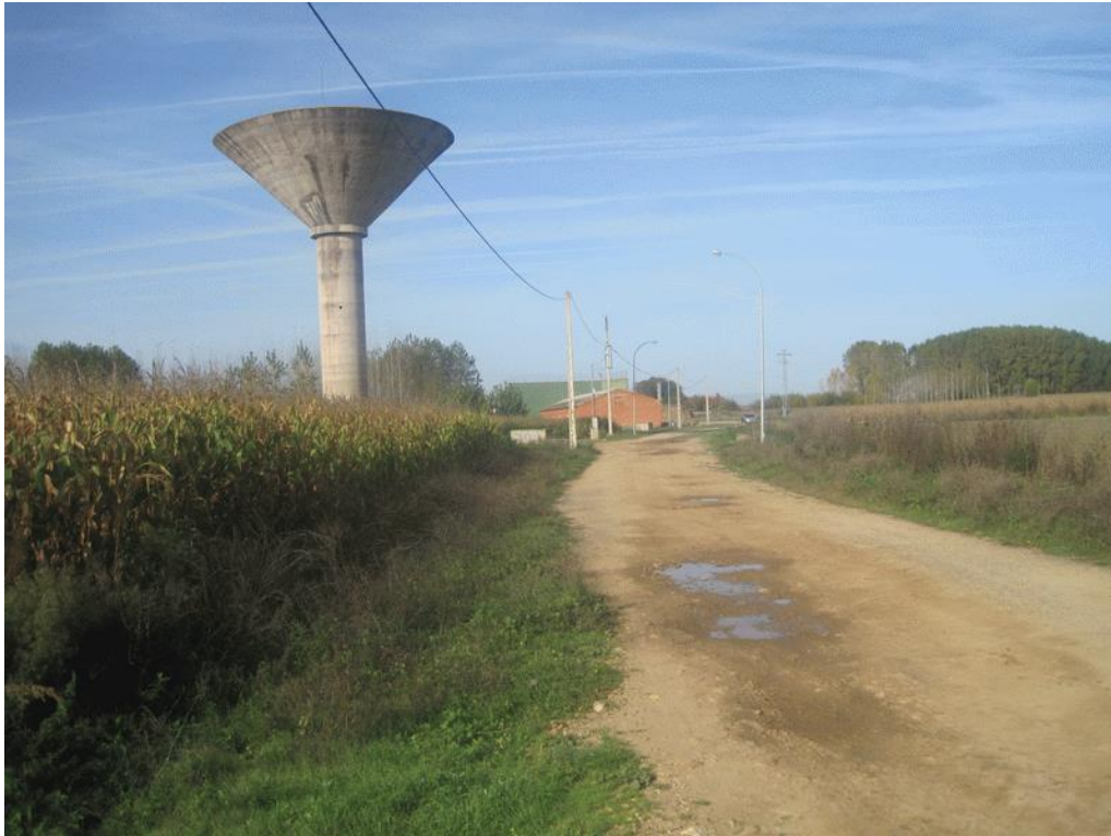
FOTOGRAFÍA 19. Depósito de agua de Oteruelo, donde se ubicará la potabilizadora municipal y la toma de agua desde la Acequia de la Presa de la Vega de Abajo, para todos los núcleos
