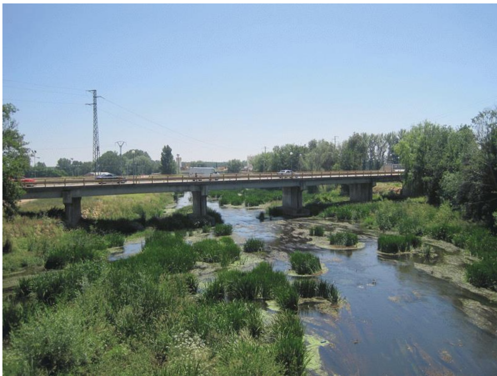
FOTOGRAFÍA 7. Vista del puente de la carretera CL-622 sobre el río Tuerto, entre Soto de la Vega y La Bañeza. La proximidad de Requejo a la cabecera comarcal es la clave de su impulso
